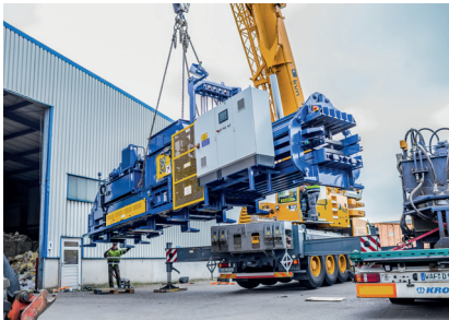
Installation einer AVOS 1810 B5-90/100
